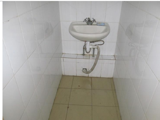
Фото №34 – Санитарно-гигиеническое помещение (раковина)
