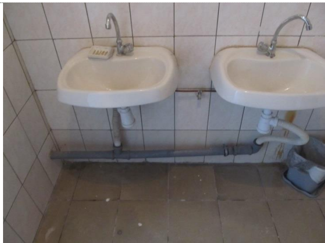
Фото №35 – Санитарно-гигиеническое помещение (раковина)
