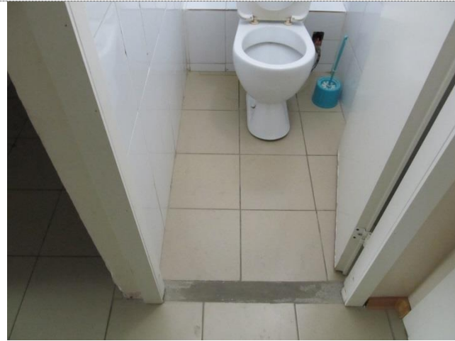
Фото №32 – Санитарно-гигиеническое помещение (кабина)
