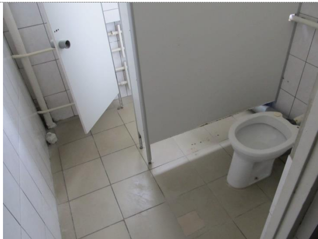
Фото №33 – Санитарно-гигиеническое помещение (кабина)
