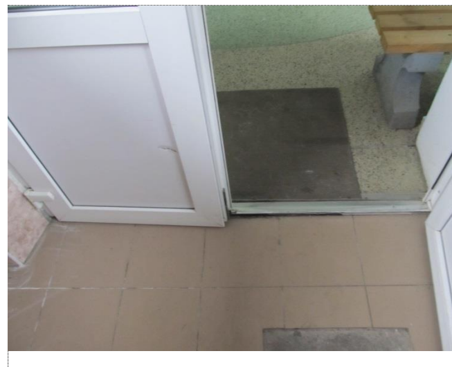
Фото №10 – Внутренняя входная дверь
