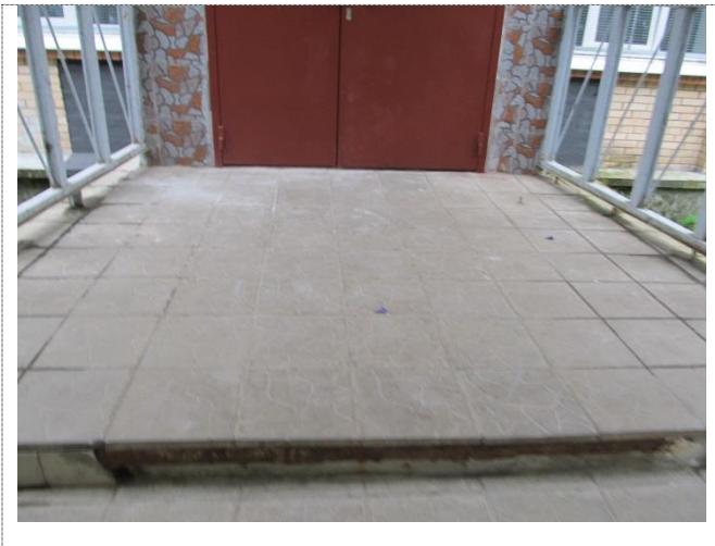
Фото №7 – Входная площадка главного входа
